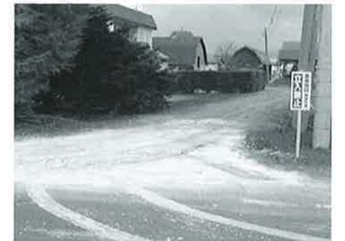
車輪跡がくっきり着くまで石灰を散布
